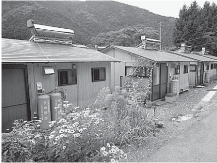
住田町・木造の仮設住宅
